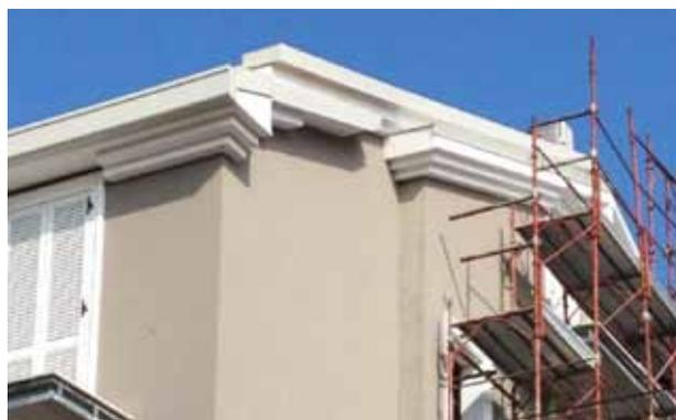
Vista di un cornicione realizzato con manufatti su misura, assemblati, lunghi due metri, unitamente agli angoli, sempre assemblati per semplificarne l'utilizzo, prodotti con **AQUAPANEL® KNAUF**
