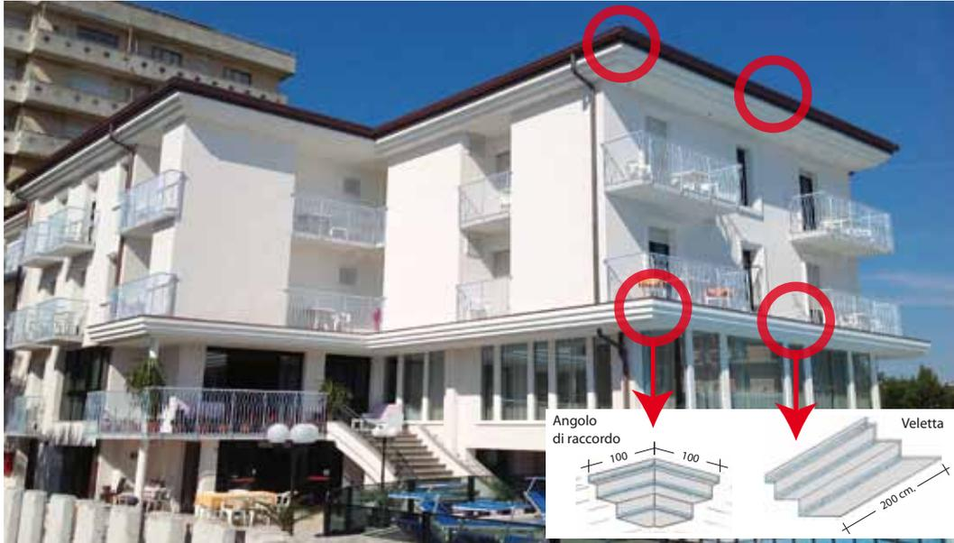
Tutti gli elementi angolati in fibrocemento (elle retti - top retti - scalettati) vengono consegnati assemblati, lunghi 200 cm. completi, su richiesta, di parasigoli forati in alluminio e con due legni sagomati per incollaggio a squadra. I due legni, avvitati, vanno tolti in cantiere, prima della posa in opera.
