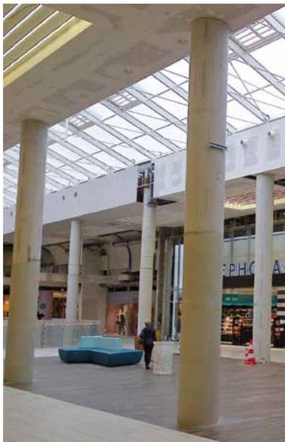
Vista di una struttura metallica con pilastri alti sei metri, di un centro commerciale, rivestiti con semicolonne prefabbricate in
