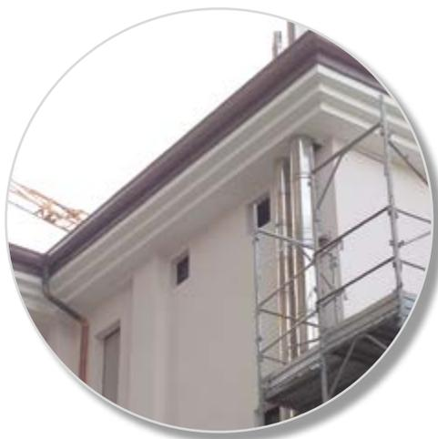
Applicazione di speciali scalette in aquapanel poste lungo l'intero perimetro di un sottotetto di un albergo. Al loro interno passano tubazioni e impianti elettrici per l'inserimento di faretti per l'illuminazione.
